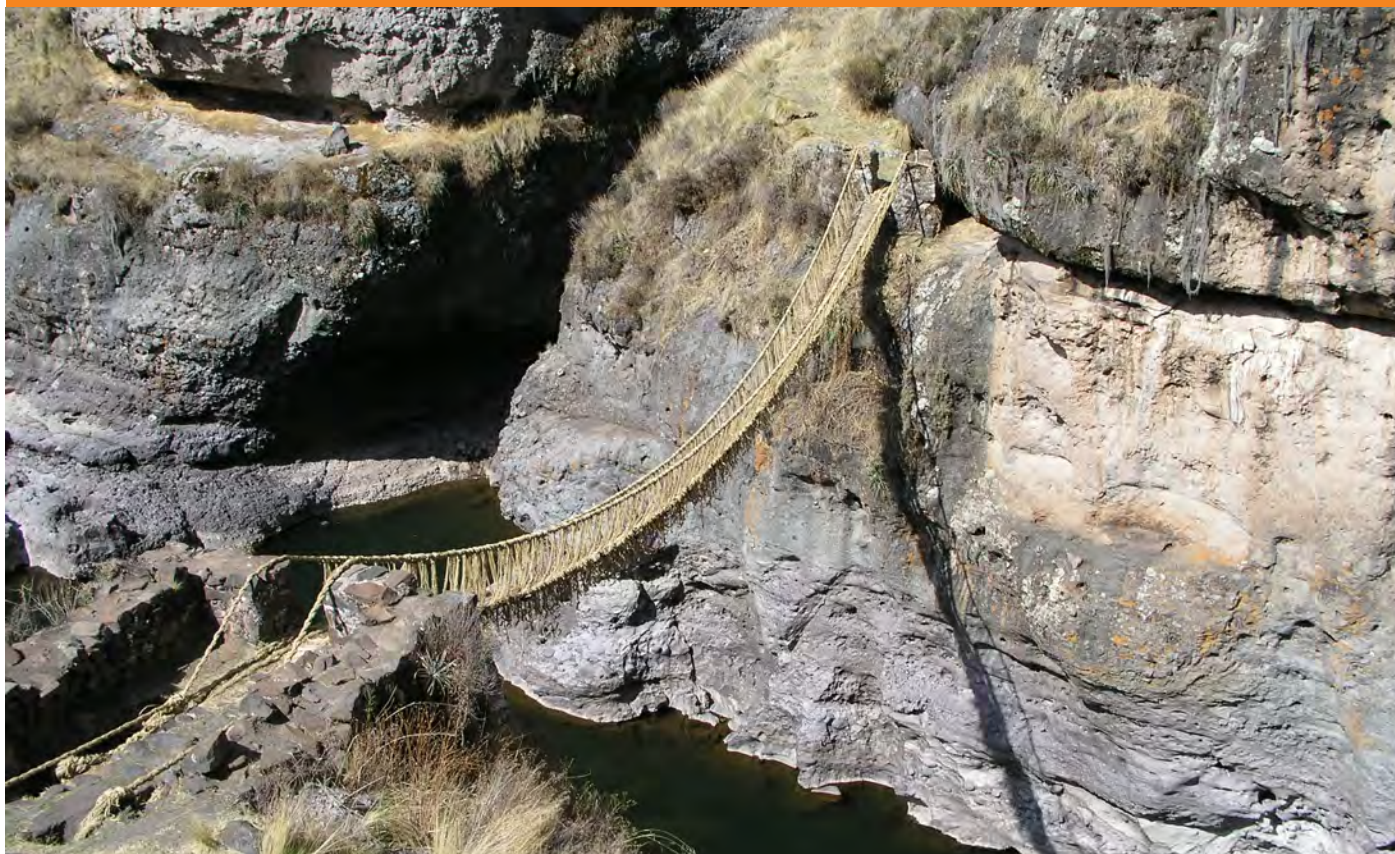
Obrázek 14: Qeswachaca, travnatý most přes řeku Apurimac, 2013. Obyvatelé obce Hampatura ho každoročně obnovují při použití tradičních metod.
